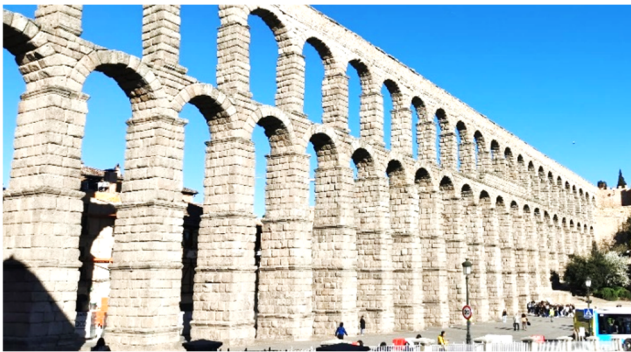
セゴビア水道橋 セゴビア県
